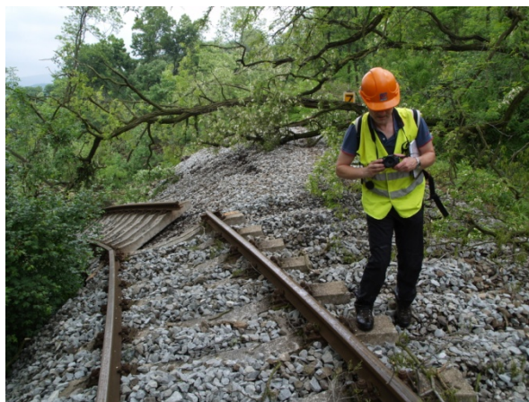
Foto 1: Porušení železničního náspu a kolejí sesuvem Dobkovičky v červnu 2013
