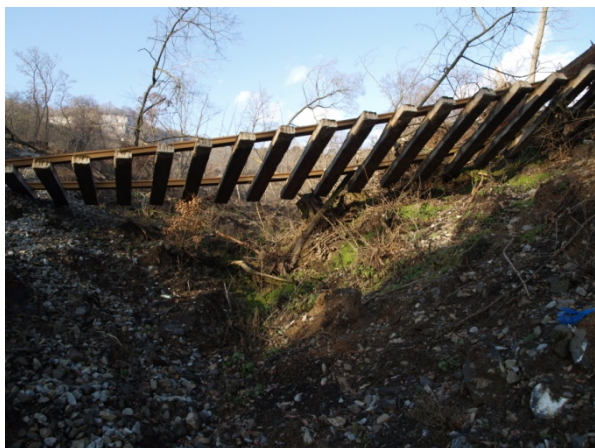
Foto 1: Porušení železničního náspu a kolejí sesuvem Dobkovičky v červnu 2013
