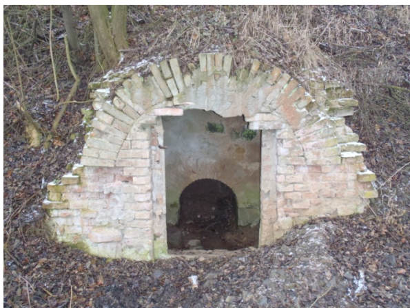
Foto 3: Zachycený pramen pod železničním náspem v oblasti sesuvu č. 8
